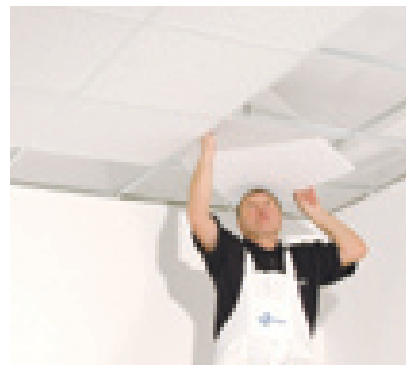
A kazettás álmennyezet behelyezése
