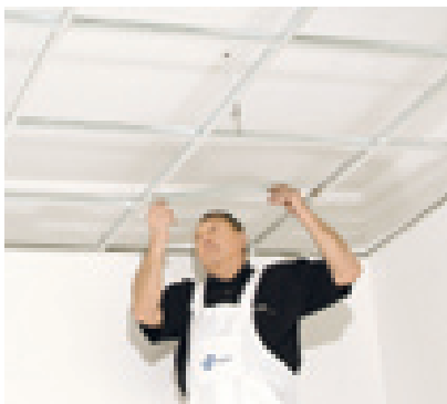
A 600 mm hosszú elválasztó tartók elhelyezése
