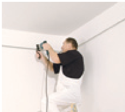
Szegőprofilok szerelése
