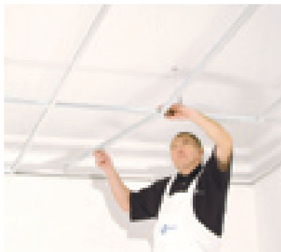
Az 1200 mm hosszú kereszttartók elhelyezése
