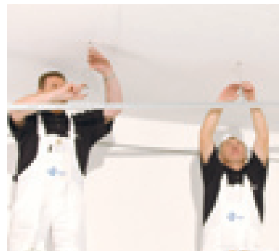
A főtartó (pl. CT24 vagy QT24) elhelyezése
